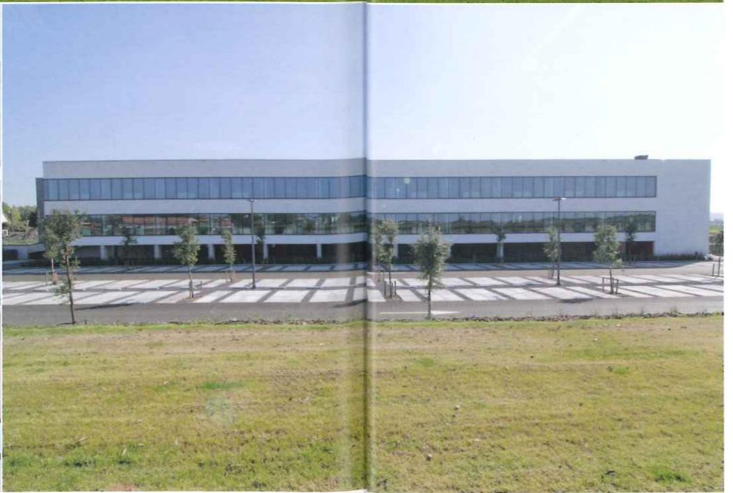
twee balkvormige volumes. Het geheel bestaat hoofdzakelijk uit courante wandelementen en structurbalken. Iets opvallender zijn de minder industriële L-elementen geïntegreerd aan de overloopzones in het atrium. De uitstekende gevel vooraan is architectonisch beton."
